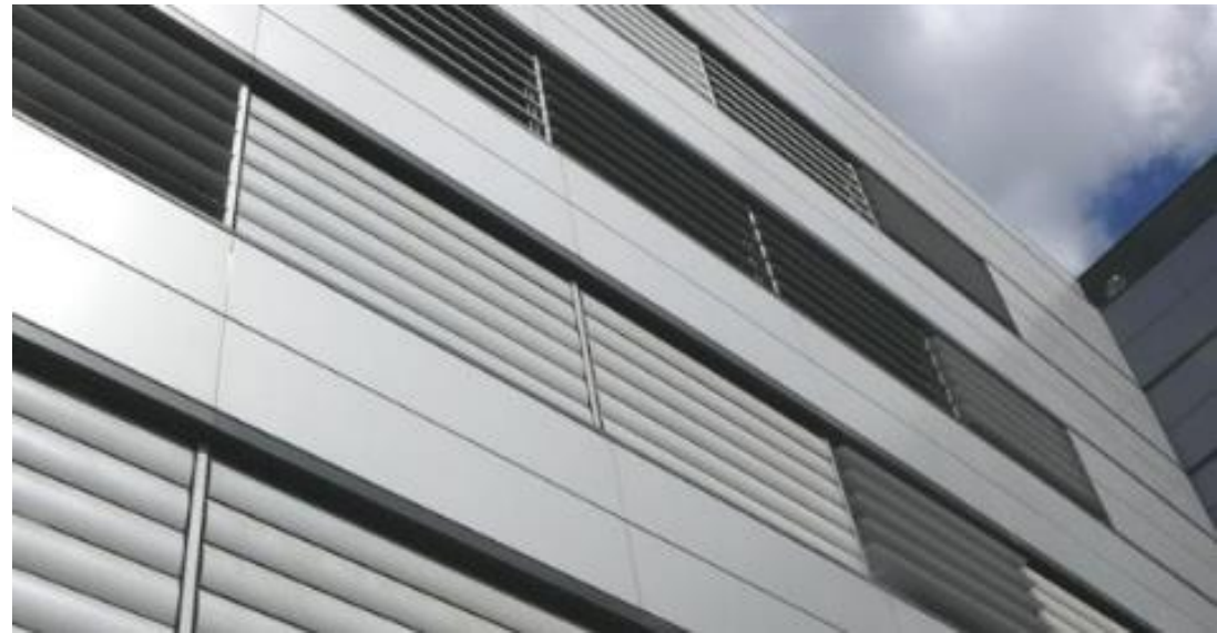
Pomični brisoleji – zaštita od sunčevog zračenja
